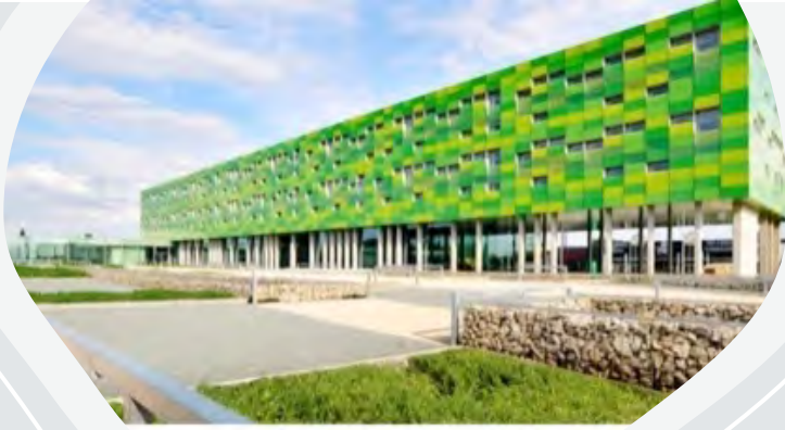
Boorputten / 120 kW verwarming + 80 kW koeling Boorputten / Torhout
